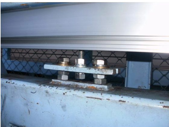
写真-5 吊り車連結部分(2)
