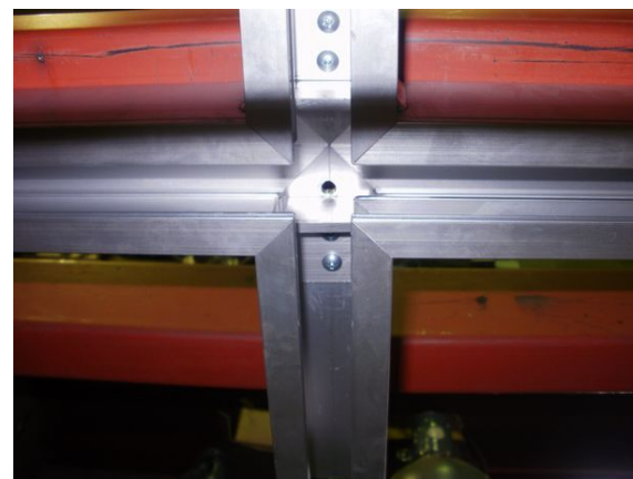
写真 - 6 十字ポイント部分
